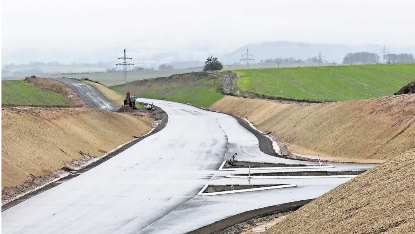
Die B252-Baustelle zwischen Simtshausen und Niederasphe.
